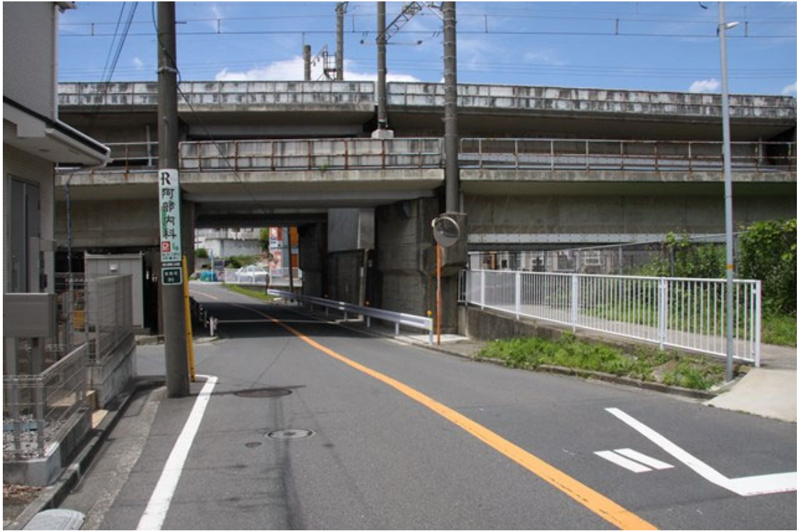
根岸線南側から
