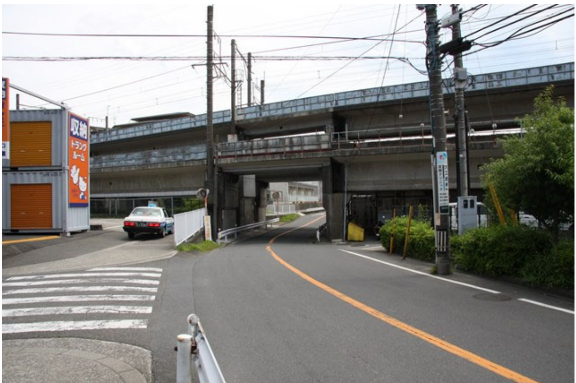
根岸線北側から
