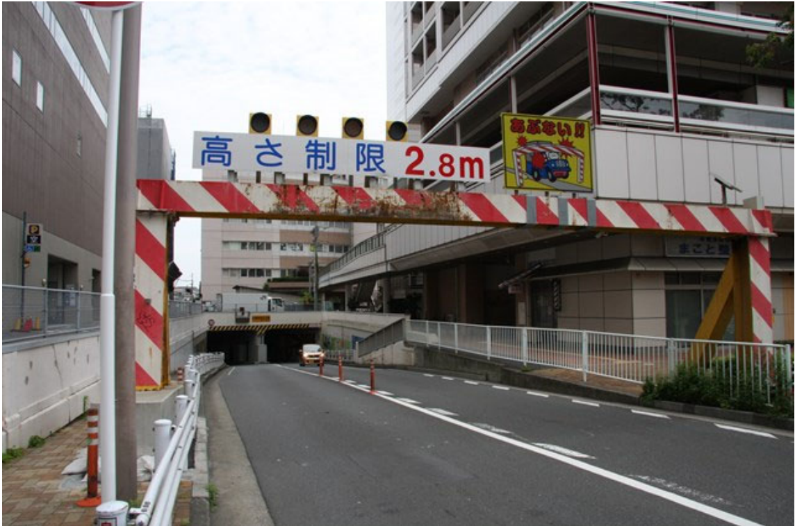
京急線側から
