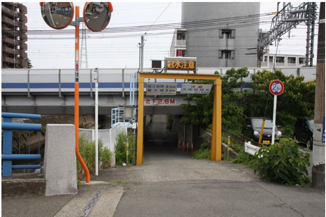
矢上川上流側から
