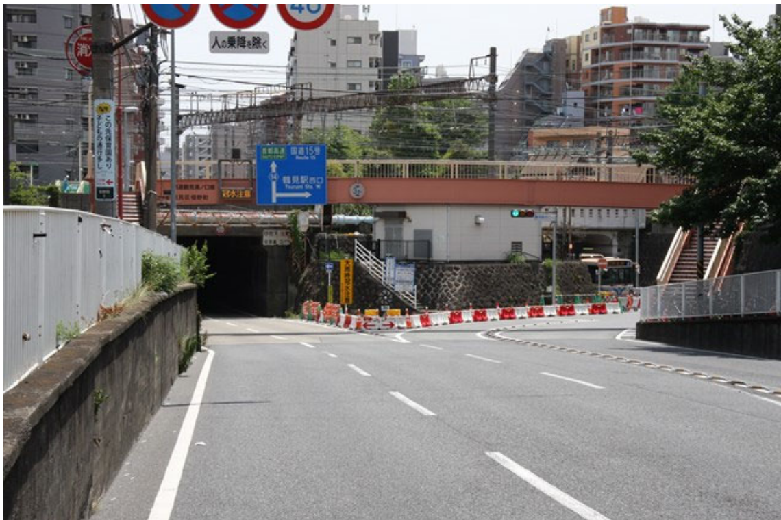
港北区方面側から
