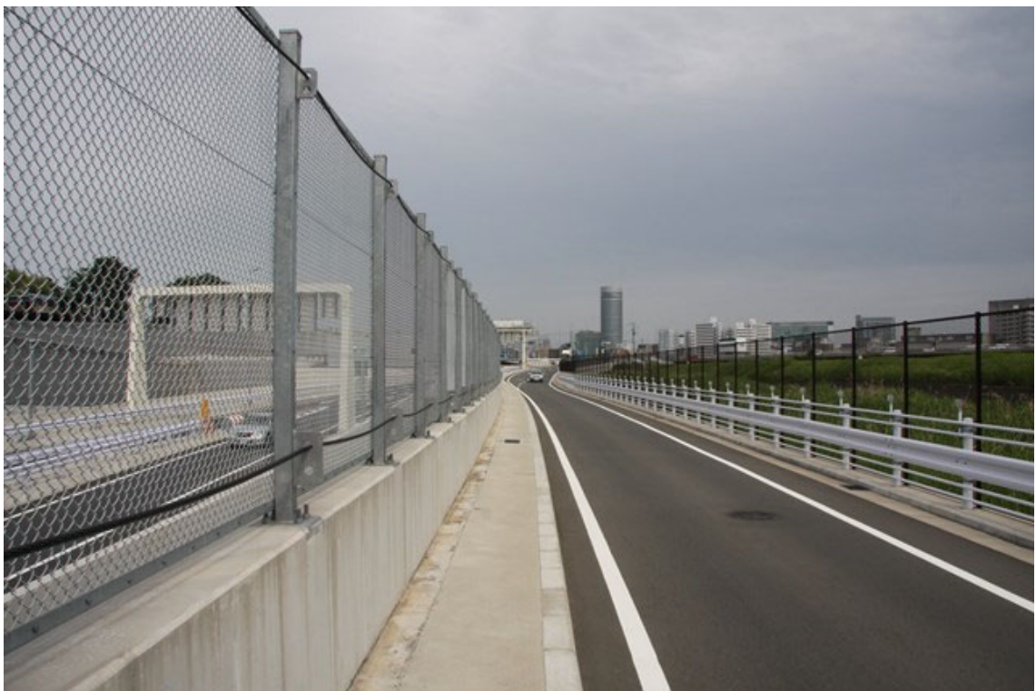
鶴見川上流側から
